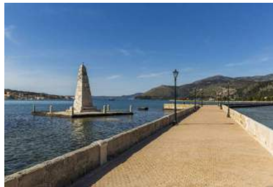
Εικόνα 22. Η γέφυρα Δεβοσέτου σήμερα
