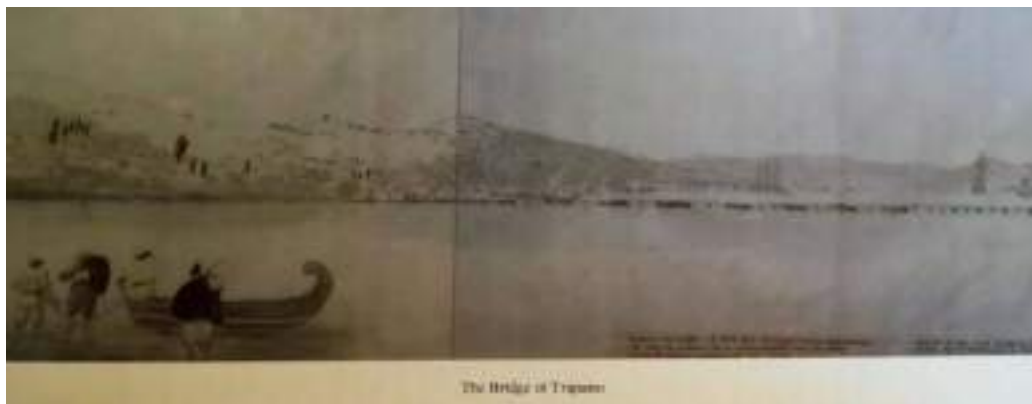
Εικόνα 16. Στο βάθος φαίνονται οι προσωρινές ξύλινες υποστυλώσεις της πρώτης γέφυρας, Δεμπόνος
