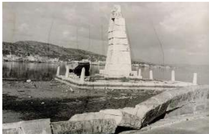
Εικόνα 21. Το σημείο στην κολώνα μετά το σεισμό
