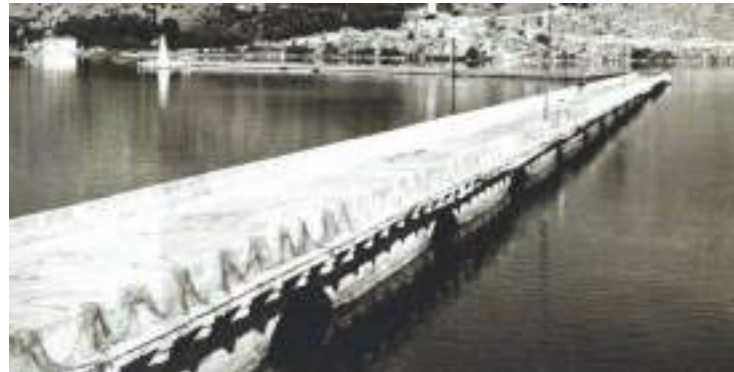
Εικόνα 19. Οι μπούκες που επιτρέπουν την ανταλλαγή μεταξύ θάλασσας και λιμνοθάλασσας
