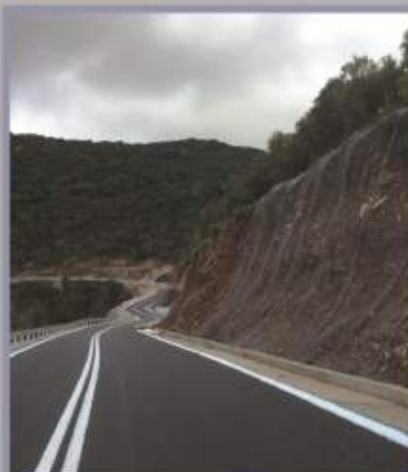
Βελτίωση-διαπλάτυνση δρόμου_Κούβελας Μεσσηνίας
