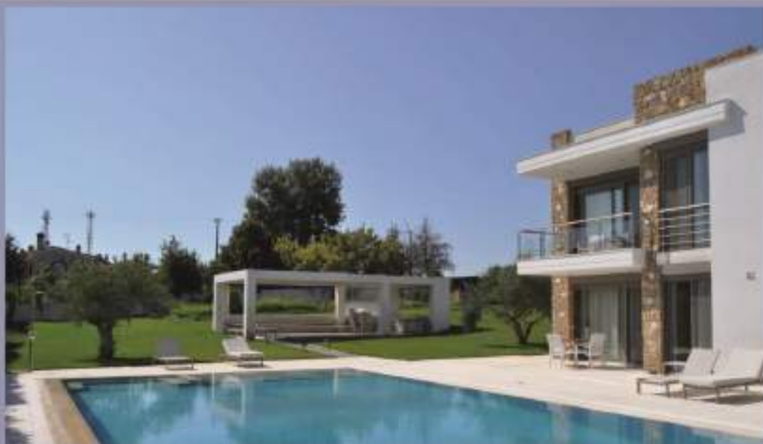
Κατασκευή εξοχικών κατοικιών_Άθως Χαλκιδικής
