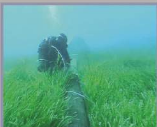
Κατασκευή υποθαλάσσιου αγωγού_ Σκάλα Κεφαλονιάς
