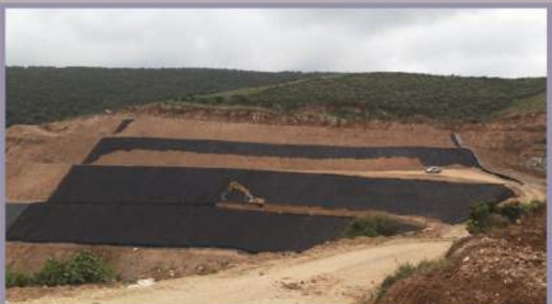
Αποκατάσταση ΧΑΔΑ Πελοποννήσου
