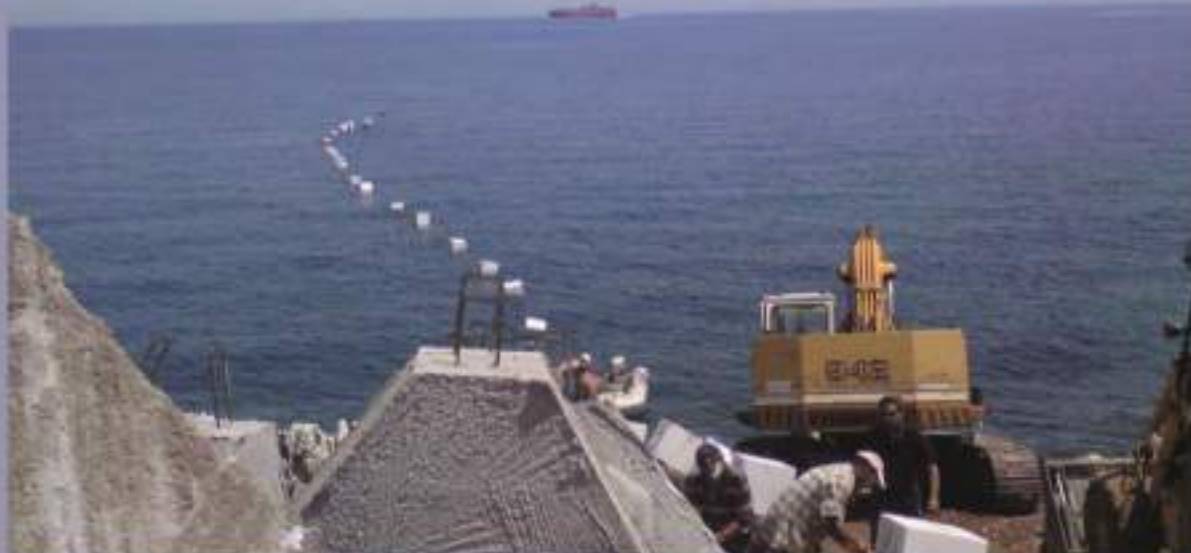
Κατασκευή υποθαλάσσιου αγωγού_Σκάλα Κεφαλονιάς
