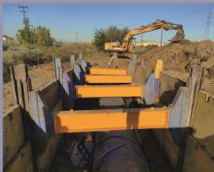
Επισκευή αγωγού ΕΥΑΘ_Θεσσαλονίκη
